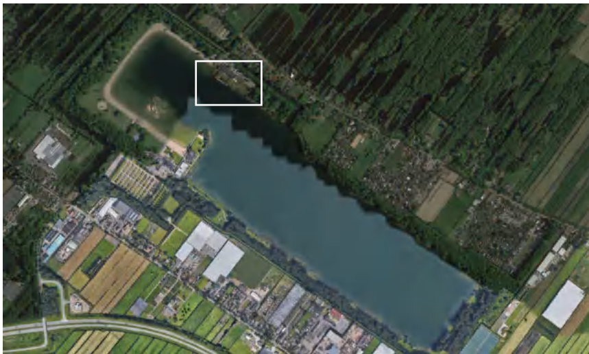
Landschappelijke ligging van het wellnesscentrum aan de Maarseveense Plassen
