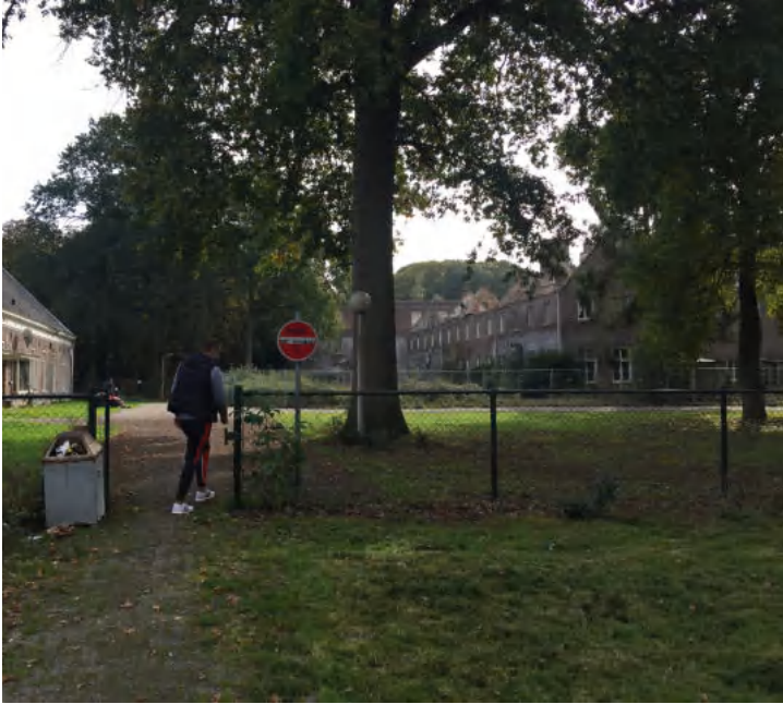
Voorzijde bij koetshuis en gebouwencomplex
